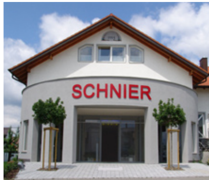
Firmengeäude in Reutlingen-Rommelsbach
